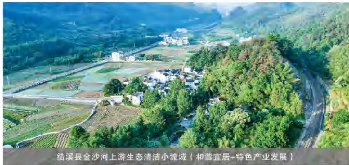
绩溪县金沙河上游生态清洁小流域（鱼鳞坝+宜居水环境治理）
