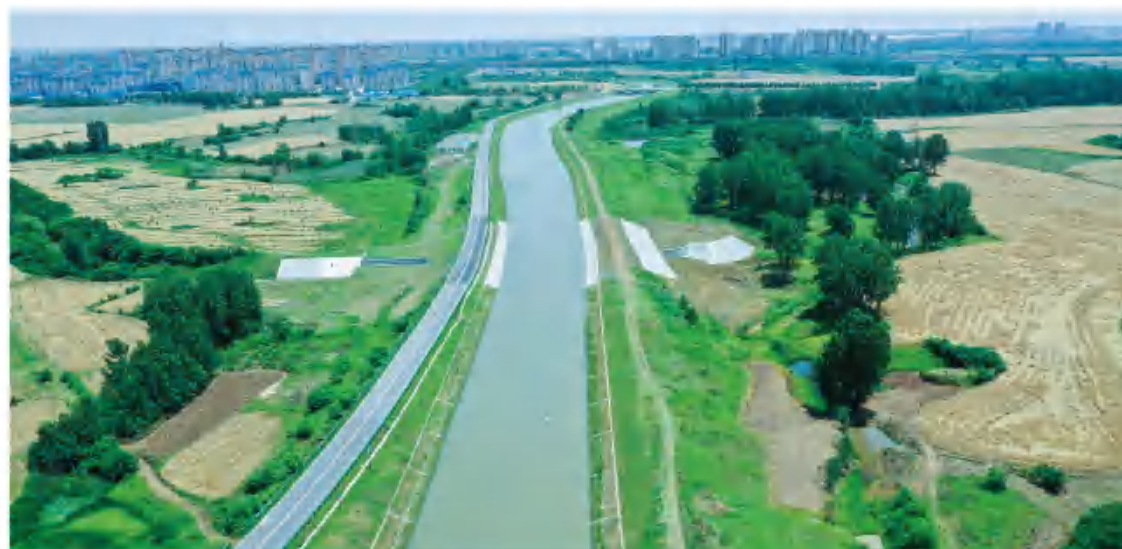
安徽省淠史杭灌区续建配套与现代化改造工程（二期）边坡综合整治
