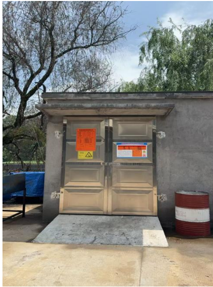
危险废物仓库现场照片
