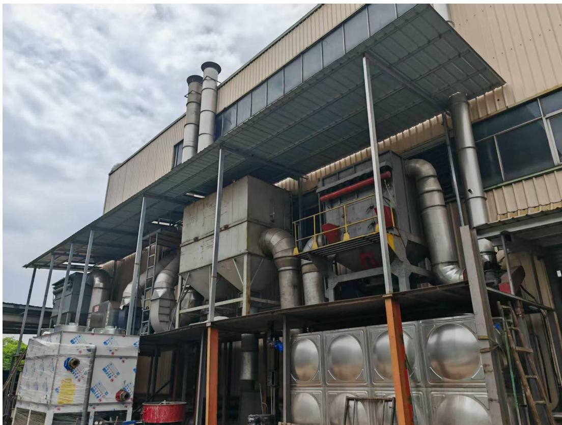
DA001 布袋除尘、DA002 布袋除尘+过滤棉+二级活性炭吸附、DA003 布袋除尘
