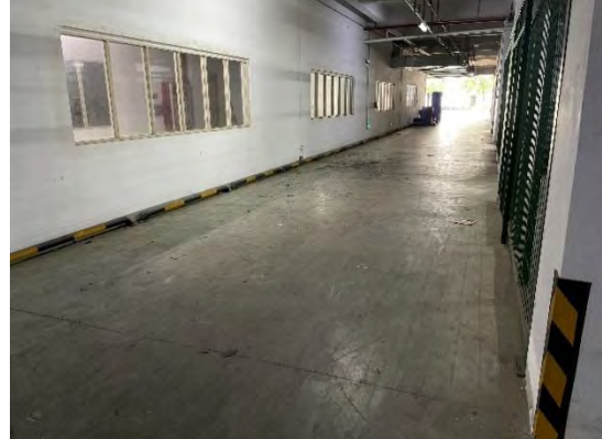
正下方仓库外通道
