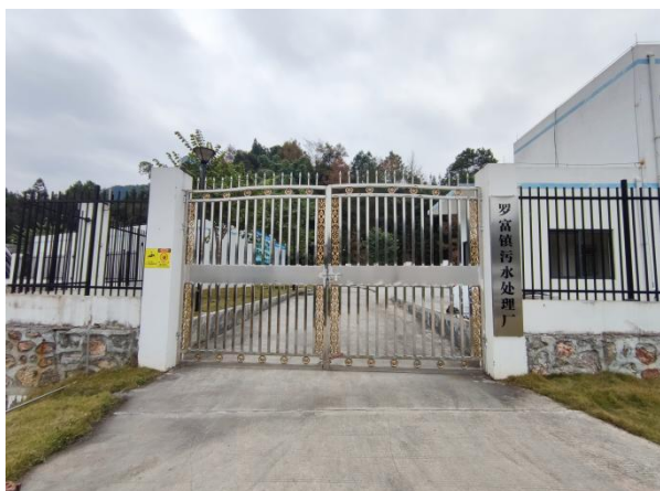
南丹县罗富镇污水处理厂
