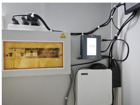
图 5 固定式辐射剂量监测仪
