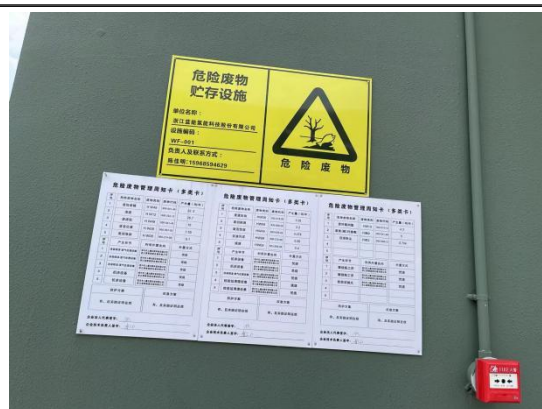
图15 危废贮存间“危废废物贮存设施”标签
