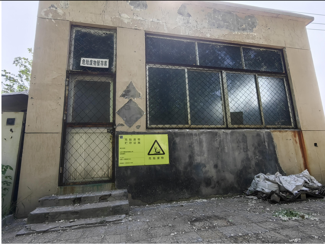
图 5 危废暂存间外部
