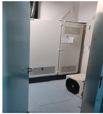
设备间现状（介入手术间南侧）
