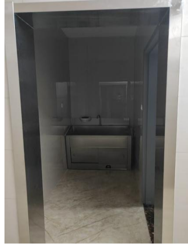
洗手间现状（介入手术间西侧）
