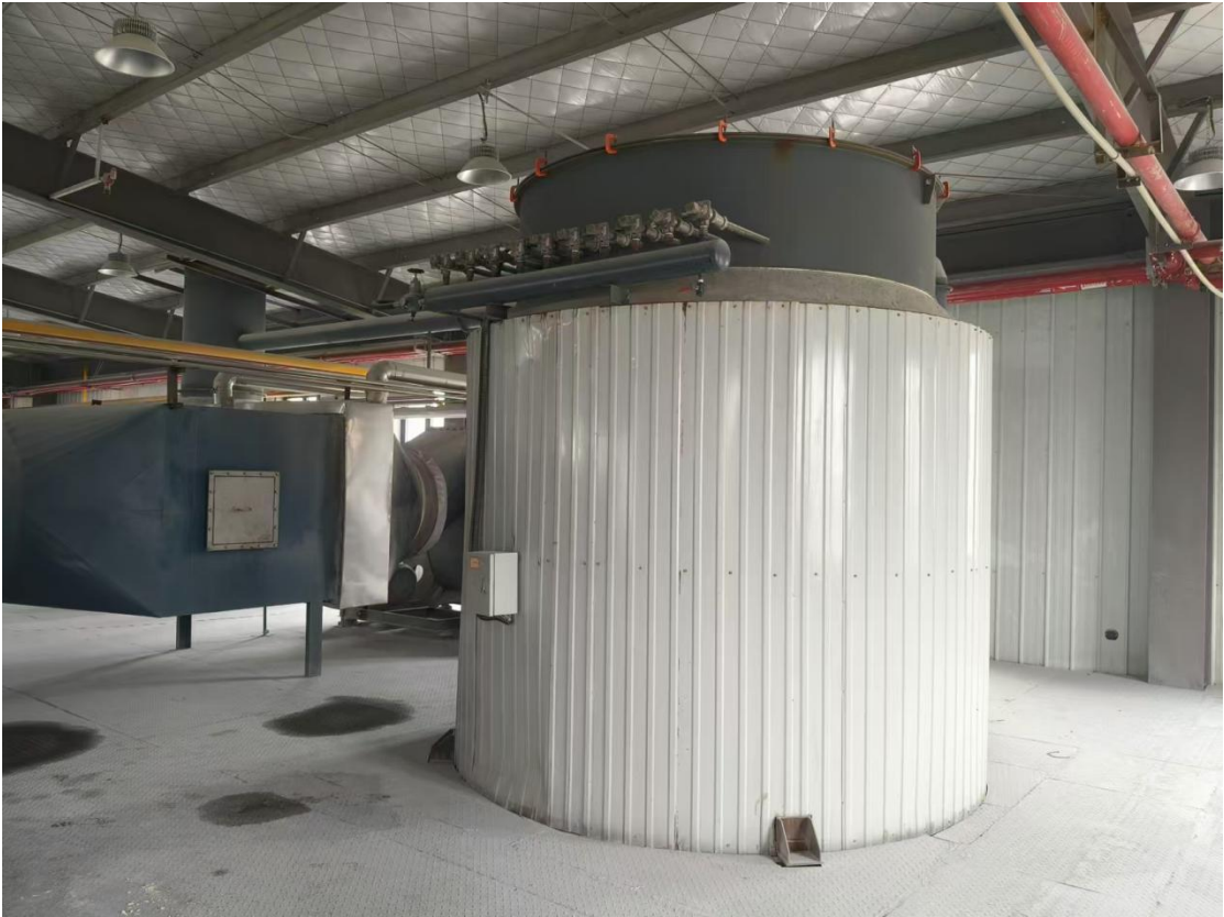
图 4.1-3 旋风除尘器
