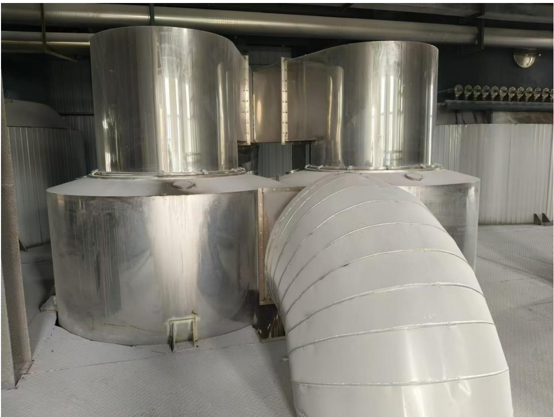
图 4.1-3 旋风除尘器
