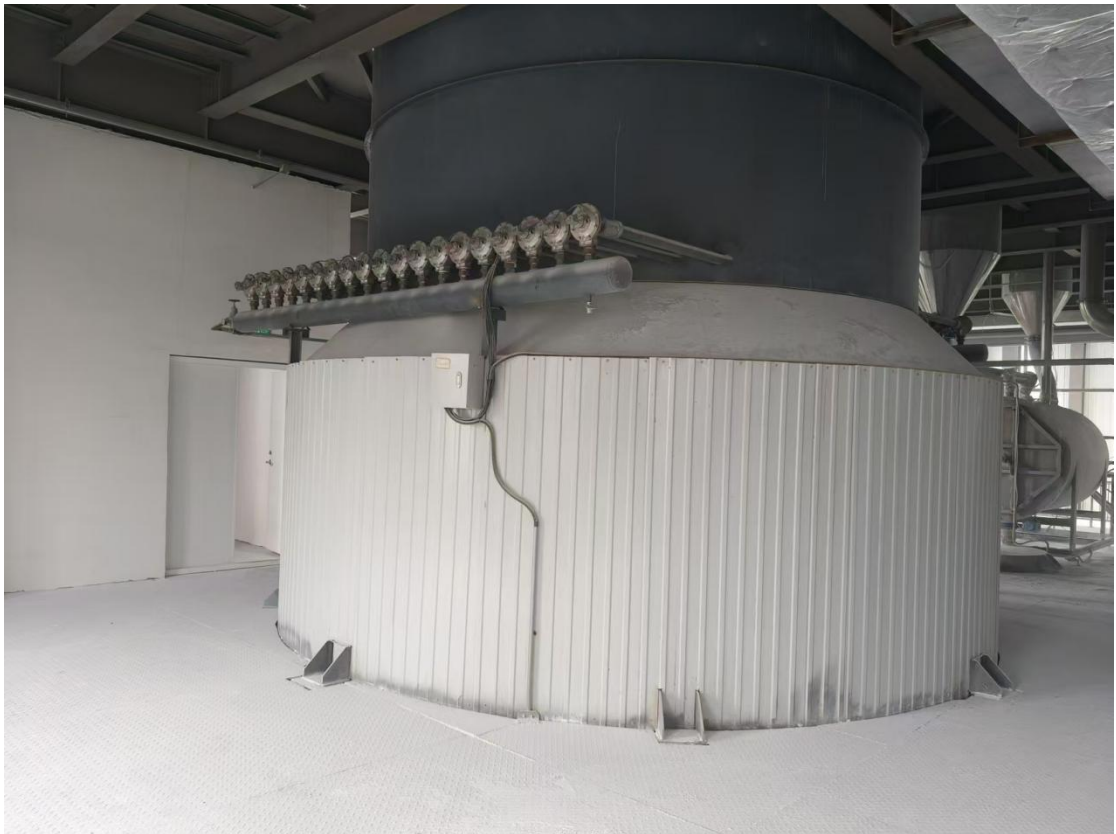
图 4.1-2 干燥塔的低氮燃烧器
