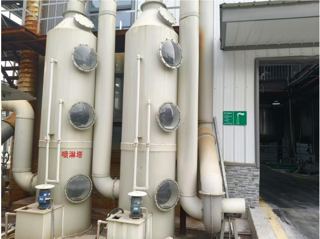
图 4.1-7 丙烯酸尾气两级洗涤装置
