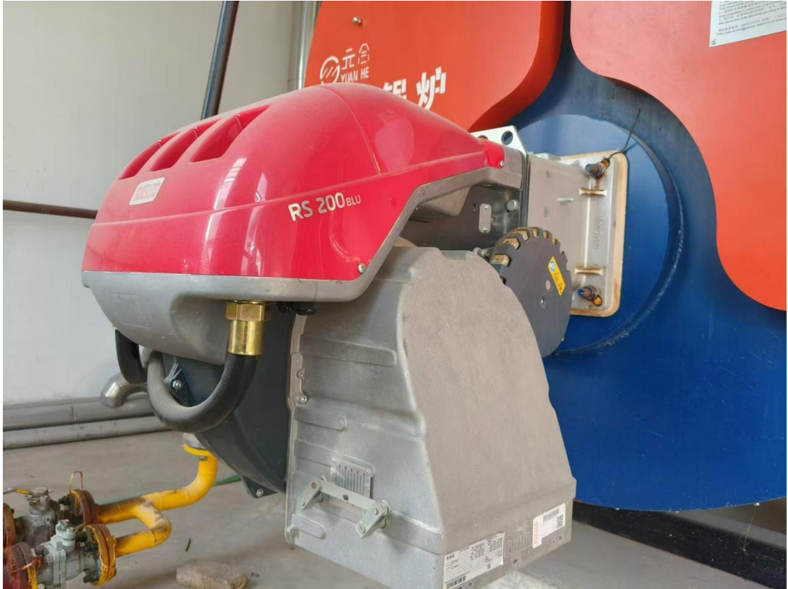
图 4.1-1 锅炉的低氮燃烧器
