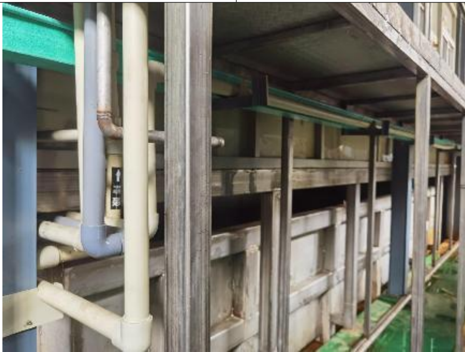
废水管线明管架空敷设
