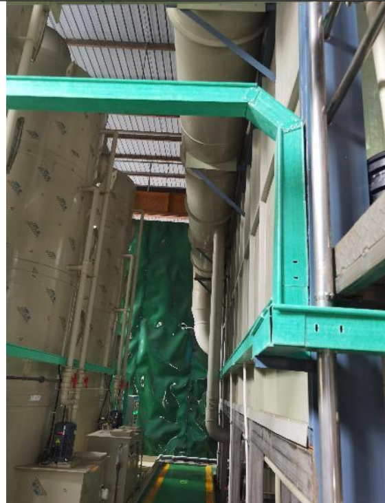
酸洗车间密闭、废气顶部收集及管道
